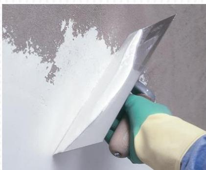
1. Si procede con una spruzzatura mediante intonacatrice di un rasante da cappotto a mò di ponte ancorante su tutta la superficie da intonacare. In prossimità di giunti e difformità di materiali (ad esempio cassonetti e spalle finestra, tagli termici solai e fondazioni), così da evitare fessurazioni dovute a movimenti o deformazioni dei diversi materiali. Questa operazione può essere limitata alle sole giunture qualora si opti per intonaci a base di gesso.
