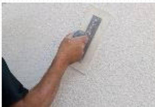
1. Si procede con una spruzzatura mediante intonacatrice di un rasante da cappotto a mò di ponte ancorante su tutta la superficie da intonacare. In prossimità di giunti e difformità di materiali (ad esempio cassonetti e spalle finestra, tagli termici solai e fondazioni), così da evitare fessurazioni dovute a movimenti o deformazioni dei diversi materiali.
