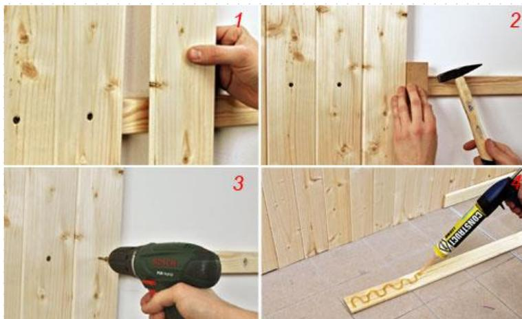
1. Posizionare i supporti per il fissaggio dei pannelli di legno o perline avvitandoli direttamente in prossimità dei distanziatori plastici del sistema, o mediante tasselli più lunghi , direttamente sul calcestruzzo strutturale.
