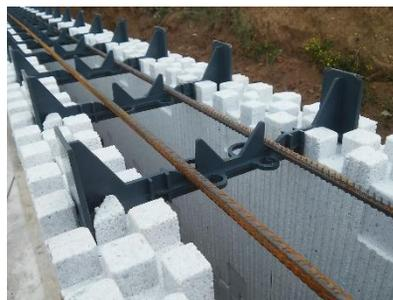
Le armature metalliche dei solai invece andranno tenute «in linea» attraverso delle legature con filo di ferro così da garantirne la posizione durante le fasi di getto, come nei classici solai gettati in opera.
