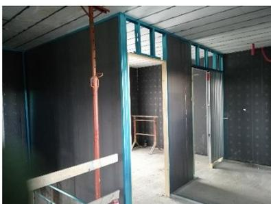
**Il Fissaggio delle controcasse**, normali o scorrevoli, avverrà con i medesimi principi dei tramezzi a secco tipo cartongesso. Si ancoreranno le stesse ai montanti affogati all'interno dei pannelli Carbon, e si fisseranno sulle guide metalliche superiore ed inferiore per rendere il tutto solidale agli impalcati.
