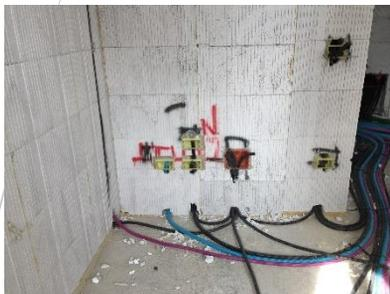
**La realizzazione degli impianti** è uno dei punti di forza del divisorio ED System, basterà infatti utilizzare un coltello a lama calda per realizzare impianti in modo rapido e preciso, senza generare macerie e polvere. Le cavità all'interno dell'elemento divisorio poi, permettono di tenere «nascosti» i corrugati o le tubazioni senza dover scavare l'intera traccia muraria.
