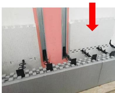
**La posa prosegue installando il pannello interno dei successivi corsi.** Il pannello interno del sistema sarà sempre «in vantaggio» rispetto a quello esterno. Questo permette di installare senza alcun intralcio o impedimento le armature metalliche di rinforzo prima di posizionare il pannello esterno.
