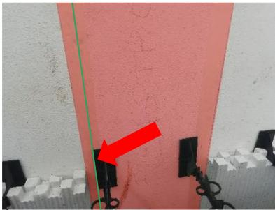
**Posizionare gli ulteriori distanziatori, e Tracciare** la linea esterna di questi riportandola in verticale. Questa sarà la guida per posizionare le sellette metalliche di collegamento alla struttura esistente. Queste serviranno a contrastare parzialmente la spinta del calcestruzzo nei punti dove non è presente il pannello interno, e a tenere il distanziatore in linea nonostante la spinta del conglomerato cementizio durante le fasi di getto.
