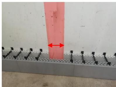
**Nelle zone di collegamento quali pilastri, travi e cordoli;** predisporre gli allargamenti rimuovendo il pannello interno del sistema. Questo garantirà il collegamento del calcestruzzo tra il nuovo guscio sismoresistente generato con il sistema e la struttura esistente creando un corpo unico.
