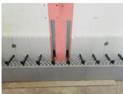
**Una volta ancorato il sistema alla struttura esistente** mediante le sellette metalliche ed i tasselli a fungo, procedere alla posa dei pannelli esterni. Questo andrà ripetuto per ogni corso successivo.
