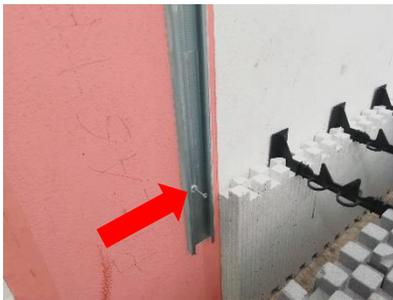
**Installare le sellette metalliche** tassellandole alla muratura esistente. Il sistema di tasselli utilizzato ed il numero dovrà essere scelto e concordato insieme alla Direzione lavori a seconda del supporto su cui si andrà ad effettuare l'operazione.
