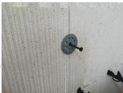
**Nelle giunte verticali** dei vari pannelli interni utilizzare dei comuni tasselli da cappotto per rendere solidale il sistema alla struttura esistente, così da non dover utilizzare ulteriori sistemi di allineamento. Questi avranno un'incidenza di circa 3/mq (vedi schema allegato 1A - pagina 5)
